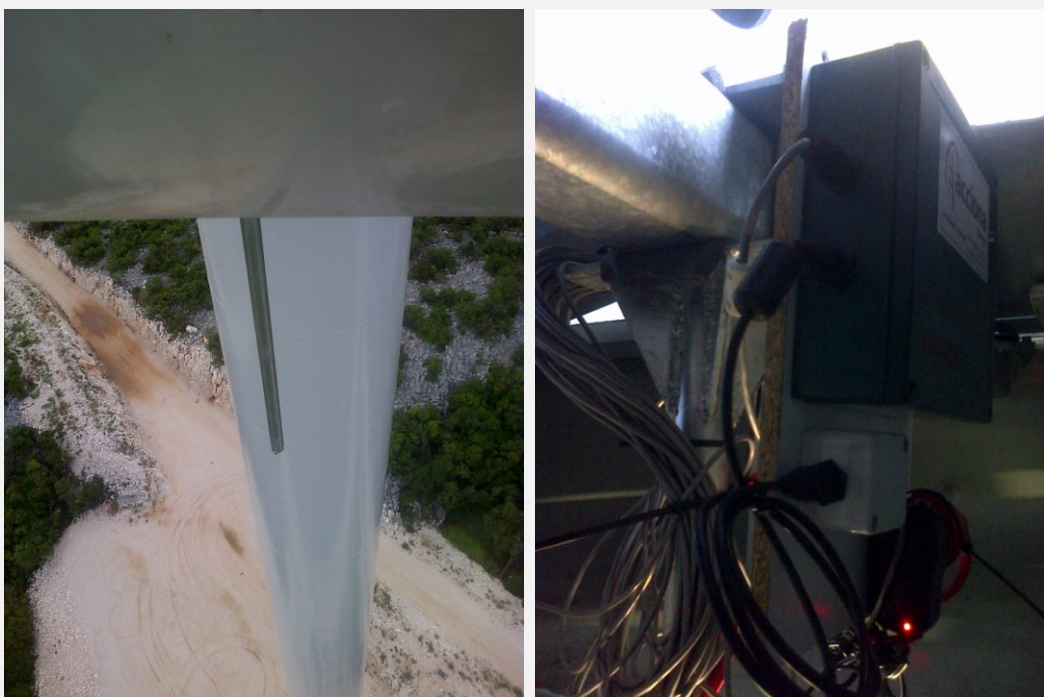
Slika 2. Lijevo: pogled na šipku koja drži mikrofon s gondola vjetroturbine. Desno: ultrazvučni snimač instaliran unutar gondola.
